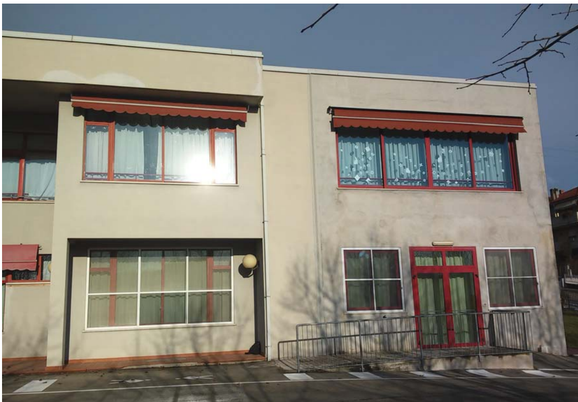
Vista del fronte sud-ovest del plesso scolastico Salvano, in corrispondenza del punto di attacco tra il blocco originario (a sinistra) e l'ampliamento del 2005 (a destra)
