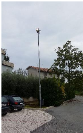
Palo dritto in acciaio con doppio proiettore
