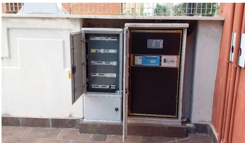
Esempio di quadro con regolatore di flusso
