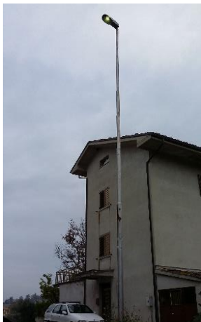
Palina in acciaio zincato con armatura stradale cut off
