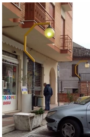
Palo in scatolato di ferro di design con arredo urbano a globo
