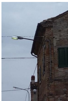
Braccio a muro con armatura stradale aperta
