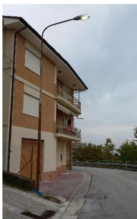
Palo curvo con armatura stradale aperta
