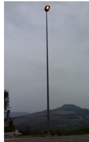
Palo dritto in acciaio con armatura stradale a vetro piano
