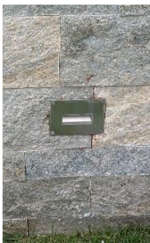
Segnapasso incassato a parete con lampada fluorescente compatta
