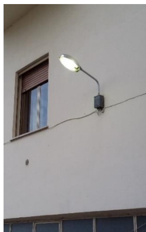
Armatura stradale aperta installata con braccio a parete
