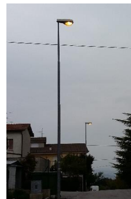
Palo dritto con armatura stradale non cut-off
