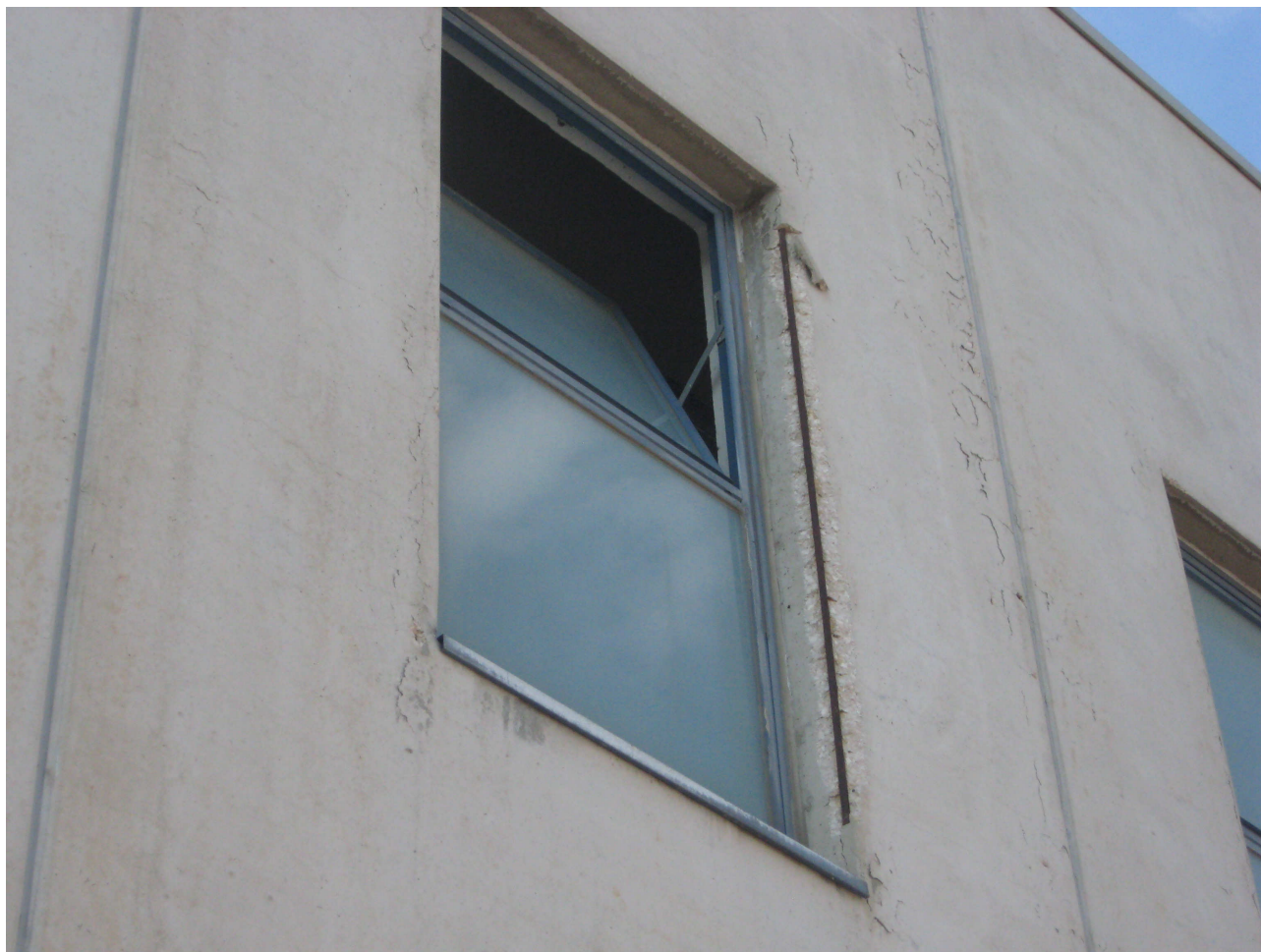
Fig. 7: degrado copriferro pannelli di tamponamento e tipologia infissi esistenti
