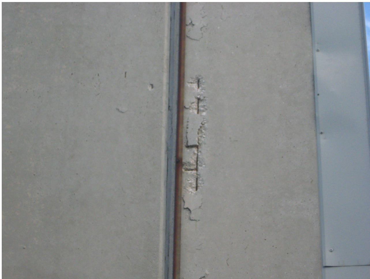
Fig. 4. degrado copriferro pannelli di tamponamento.
