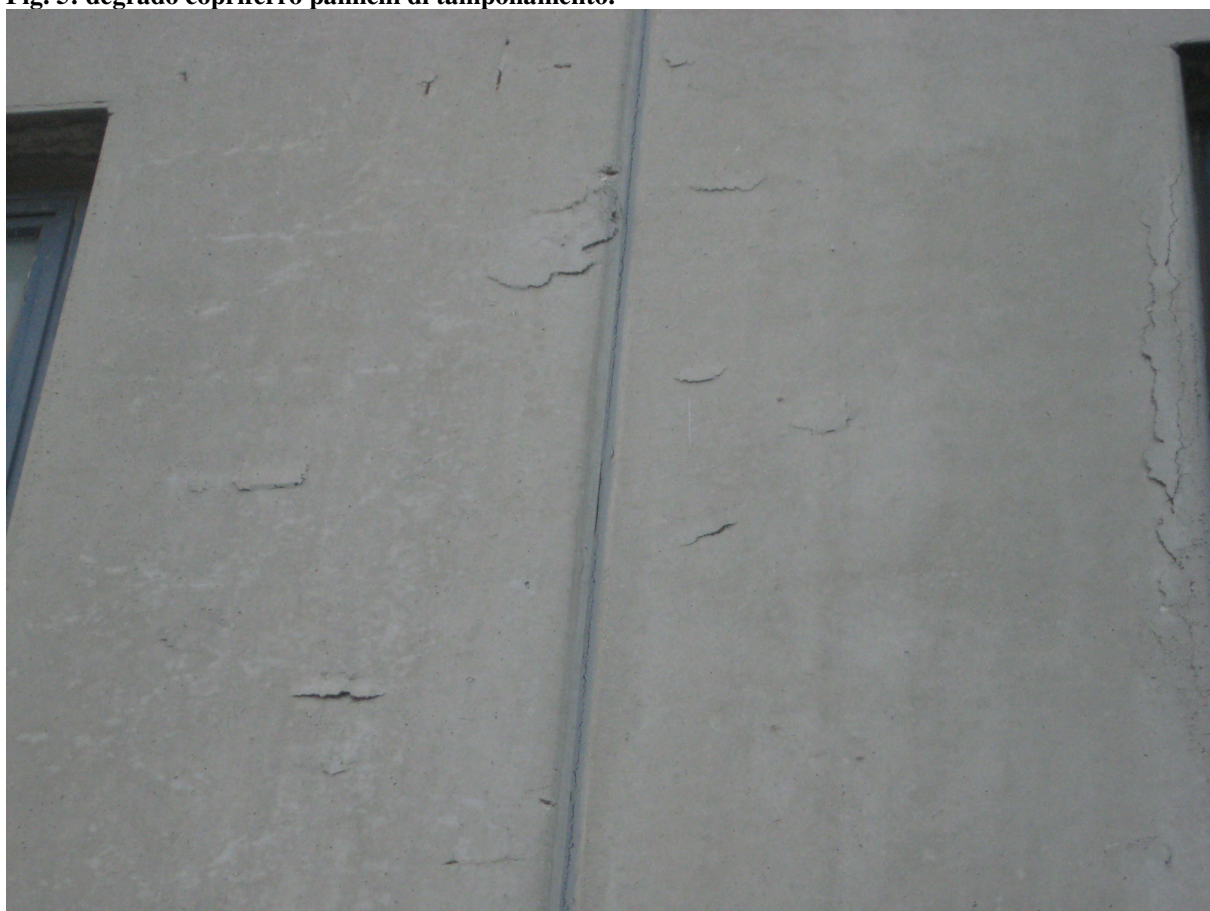
Fig 6: degrado copriferro pannelli di tamponamento.
