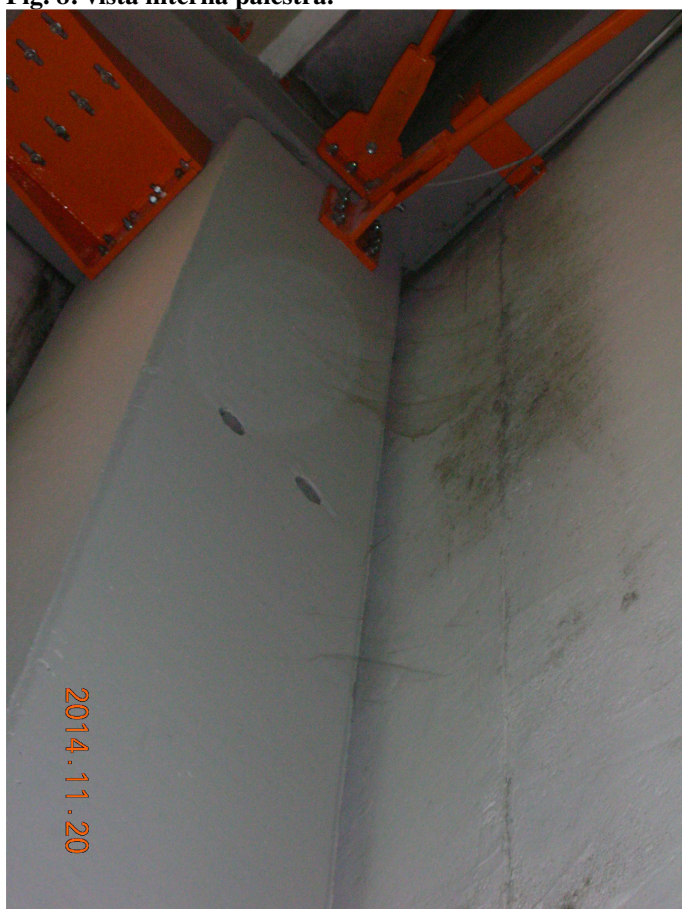
Fig. 9: fenomeni di condensa sulle pareti interne.
