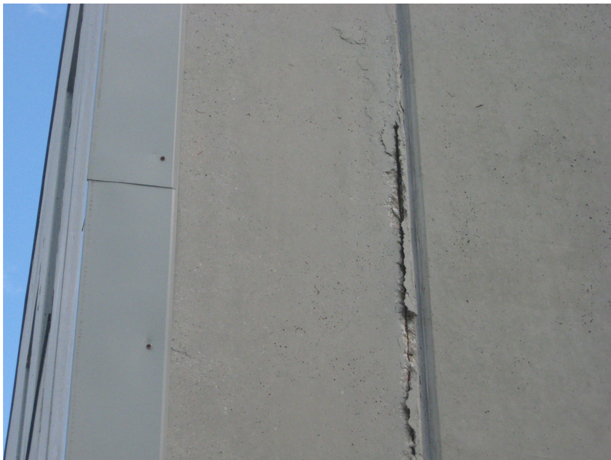
Fig. 5: degrado copriferro pannelli di tamponamento.
