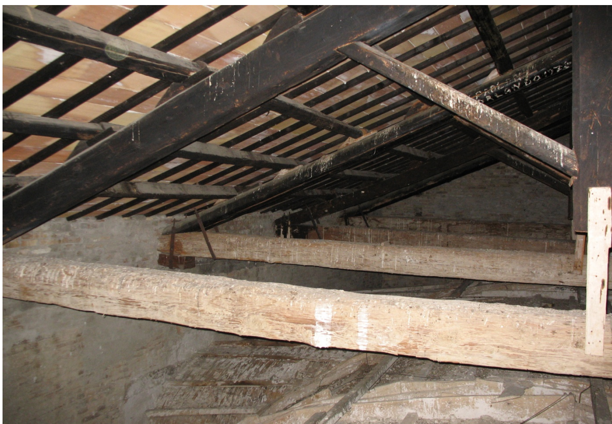
Foto n° 10 – Vista appoggi capriate e componenti sottodimensionati
