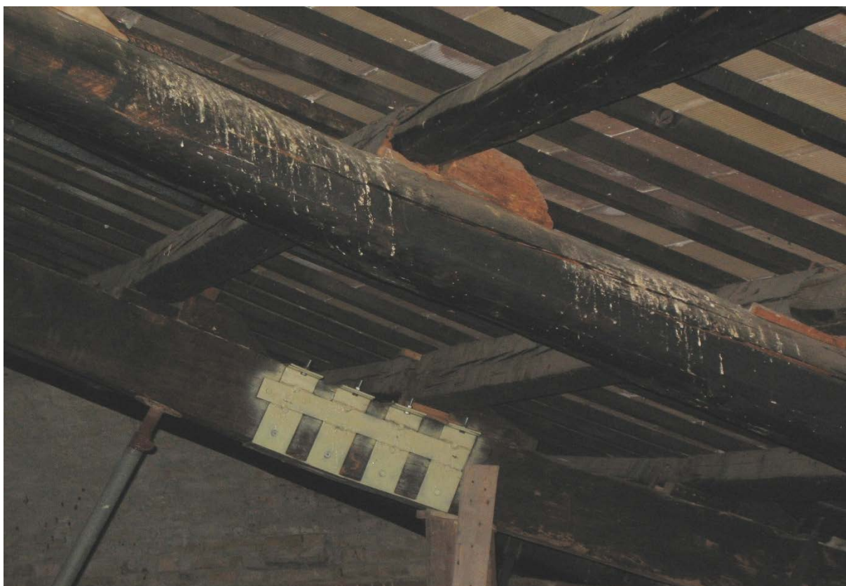
Foto n° 9 – Puntellamento di un puntone a seguito di cedimento strutturale
