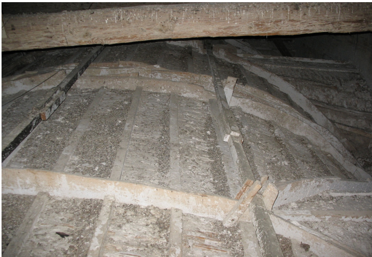
Foto n° 11 – Particolare estradosso volta in camorcanna.
