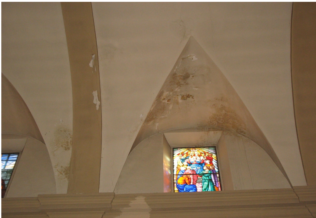
Foto n° 15 – Particolare infiltrazioni su lunette lato Sud
