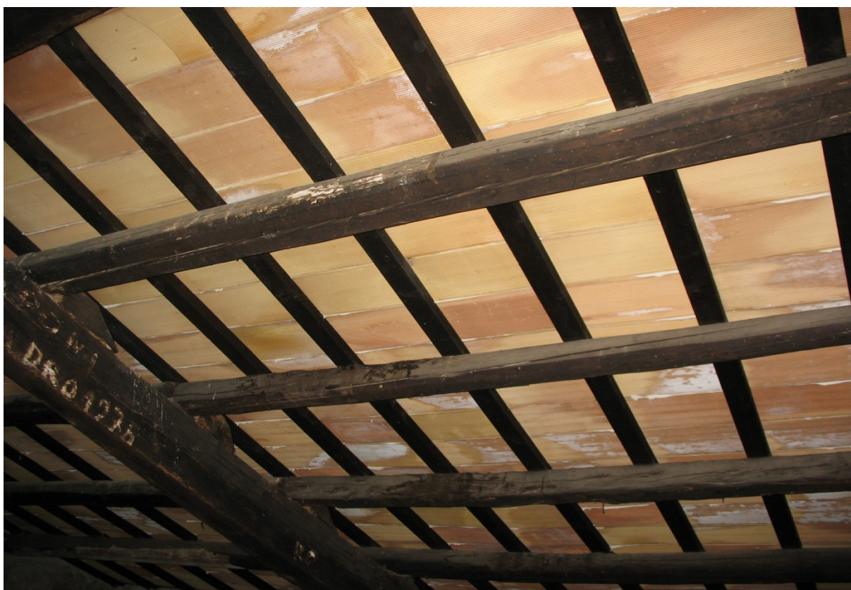
Foto n° 8 – Particolare orditura secondaria con segni di infiltrazioni e degrado
