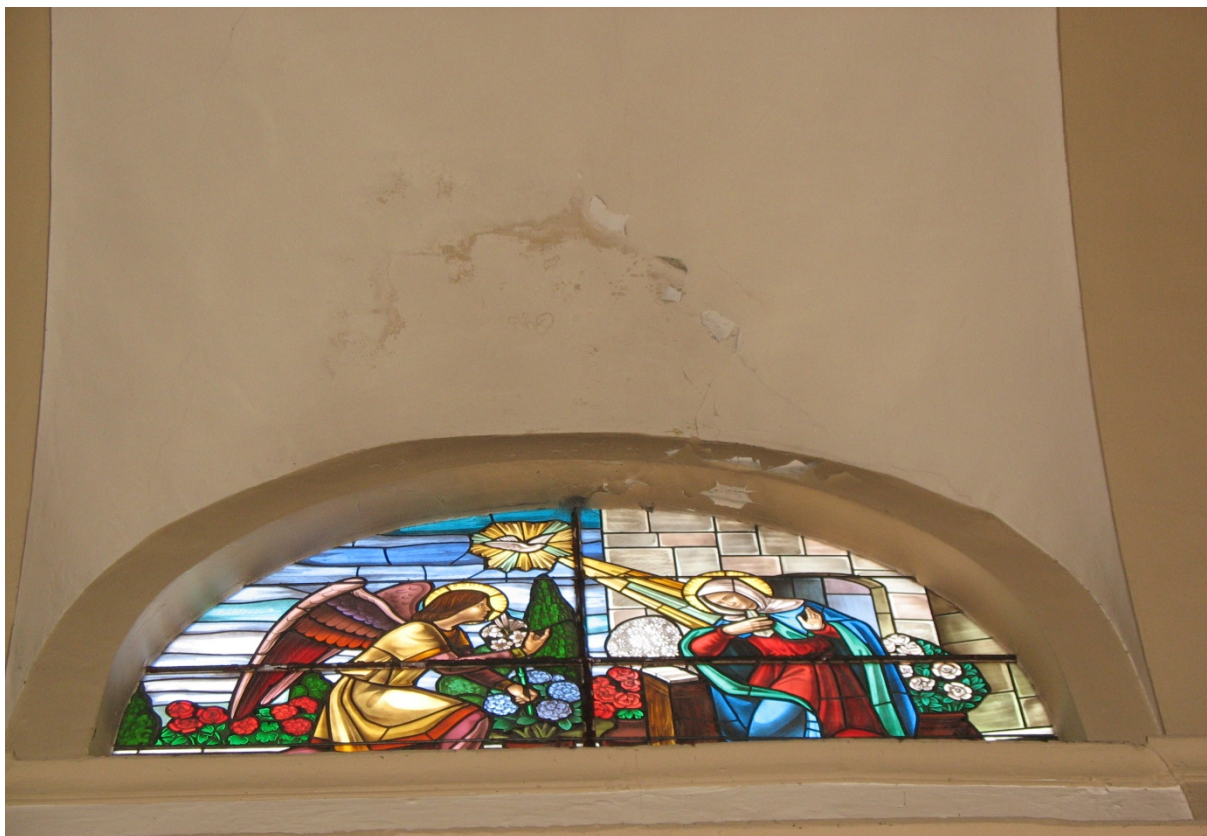
Foto n° 16 – Particolare infiltrazioni volta zona Coro.
