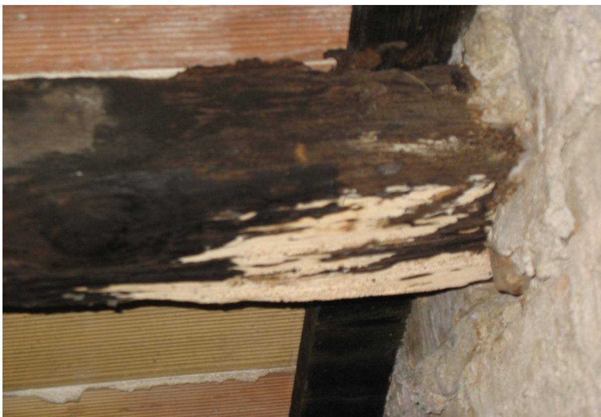
Foto n° 12 – Appoggio di un arcareccio su muratura con evidenti segni di marcescenza.
