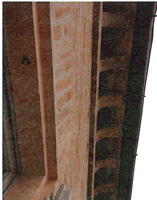
Vista di una delle aree interessate da intonachino plastico ormai compromesso, nel fronte sud e del cornicione che in alcune parti necessita di nuova stuccatura.
