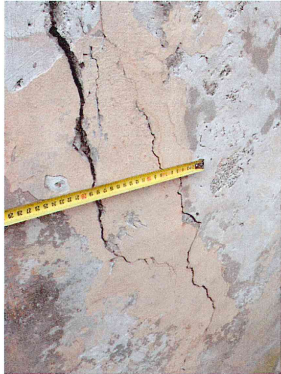
Vista di zone del fronte a est già tinteggiate con lavabile, interessate da lesioni dell'intonaco per assestamento della muratura di un contrafforte. Da notarsi le poche parti di tinta rimasta.
