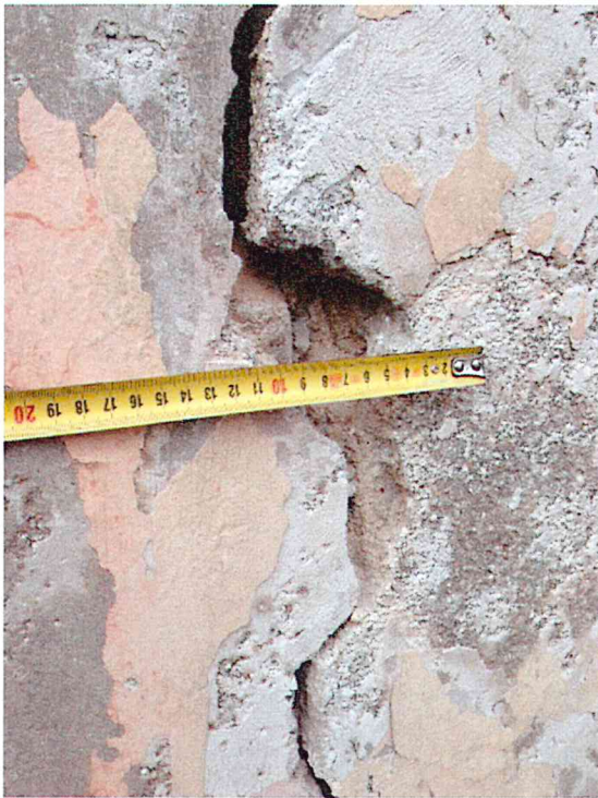
Vista di zone del fronte a est già tinteggiate con lavabile, interessate da lesioni dell'intonaco per assestamento della muratura di un contrafforte. Da notarsi le poche parti di tinta rimasta.
