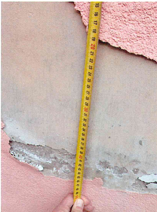
Vista di una delle aree interessate da intonachino plastico ormai compromesso, nel fronte sud e del cornicione che in alcune parti necessita di nuova stuccatura.
