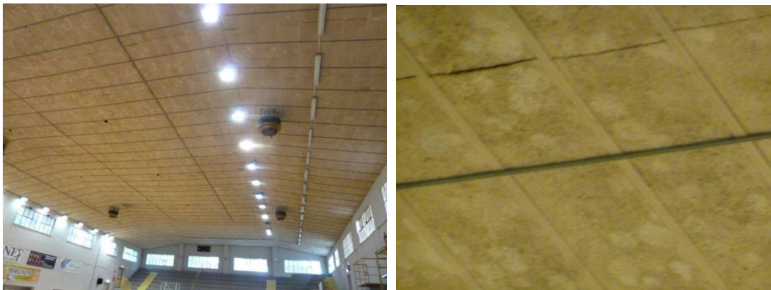
Vista interna del controsoffitto in eraclit Particolare del pannello eraclit attuale
