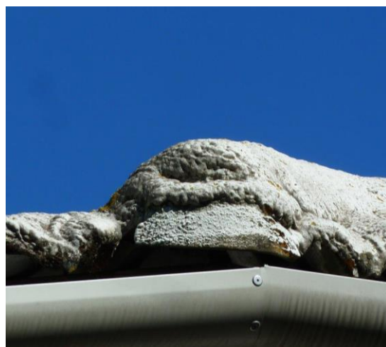
Particolare incapsulante Palabellini
