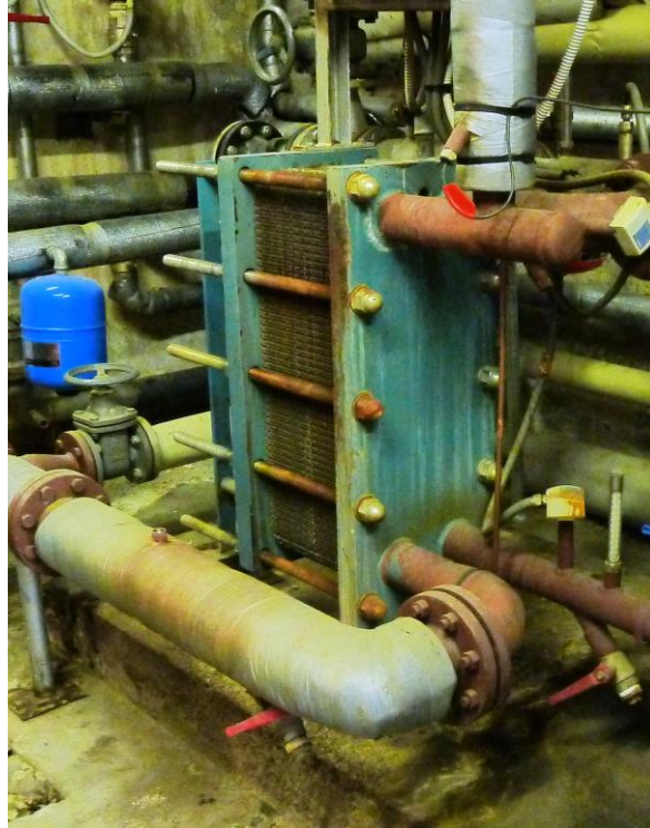
SOTTOCENTRALE DI TELERISCALDAMENTO SCAMBIATORE DI CALORE A PIASTRE –
