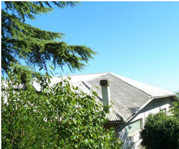
Copertura PalaBellini incapsulata
