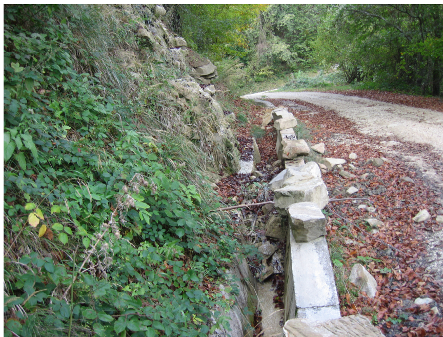
FOTO N. 2 Canale ostruito da ripristinare
