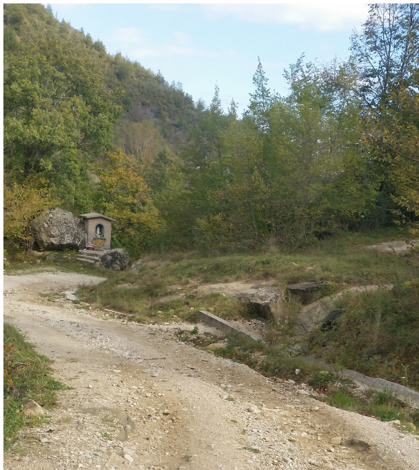
FOTO N. 7 Sgrottamenti, cunetta dissestata ed attraversamento da ripristinare
