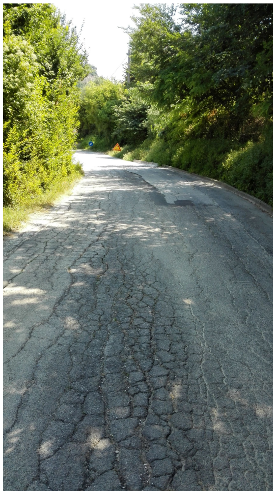
Foto 2: Strada Cerretino tratto con pavimentazione stradale danneggiata
