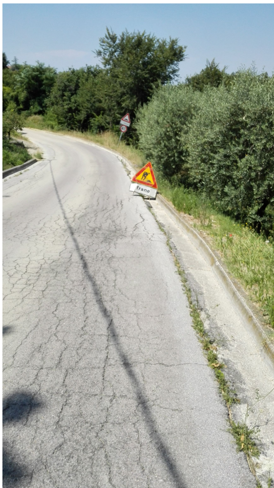
Foto 1: Strada Cerretino tratto a mezza costa con avvallamenti della pavimentazione stradale in corrispondenza del tratto in rilevato
