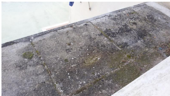
Figura 3. Particolari. Effluorescenze e umidità localizzate dovute alla scarsa tenuta del tetto.
