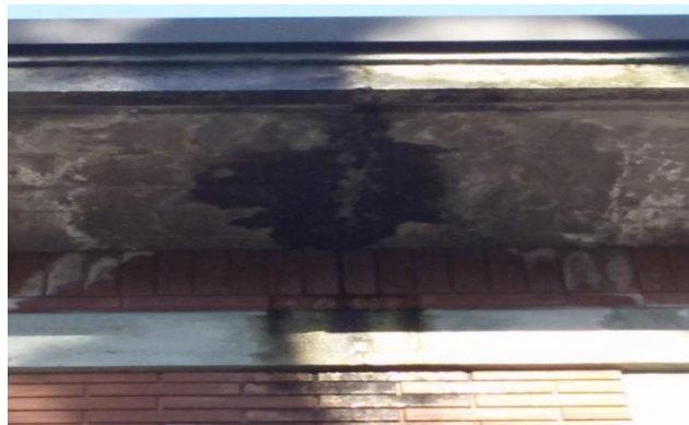
Figura 3. Particolari. Effluorescenze e umidità localizzate dovute alla scarsa tenuta del tetto.
