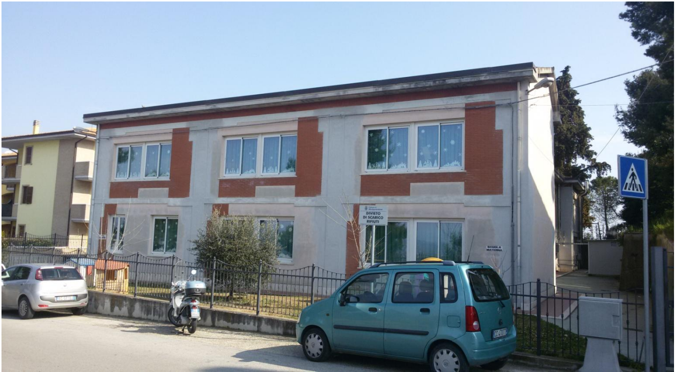
Figura 1. Prospetto esistente. Si notano le macchie sulla verniciatura e sull'intonaco esterno.
