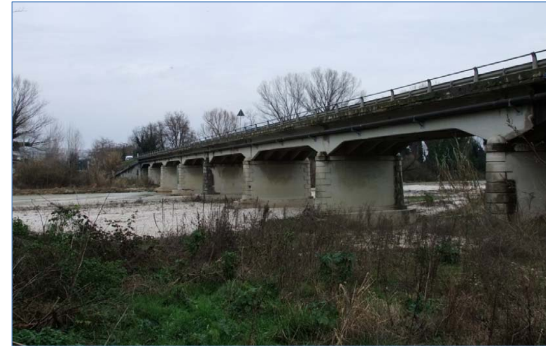
Foto A: Vista da Sud del ponte e dell'alveo con particolare della spalla sx.
