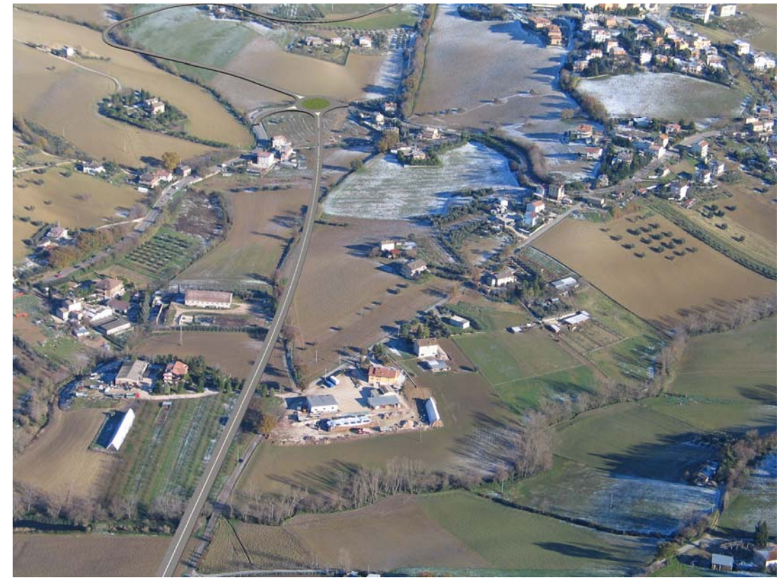
Tratto iniziale della Bretella – allaccio alla rotatoria in esercizio della Variante del Ferro
