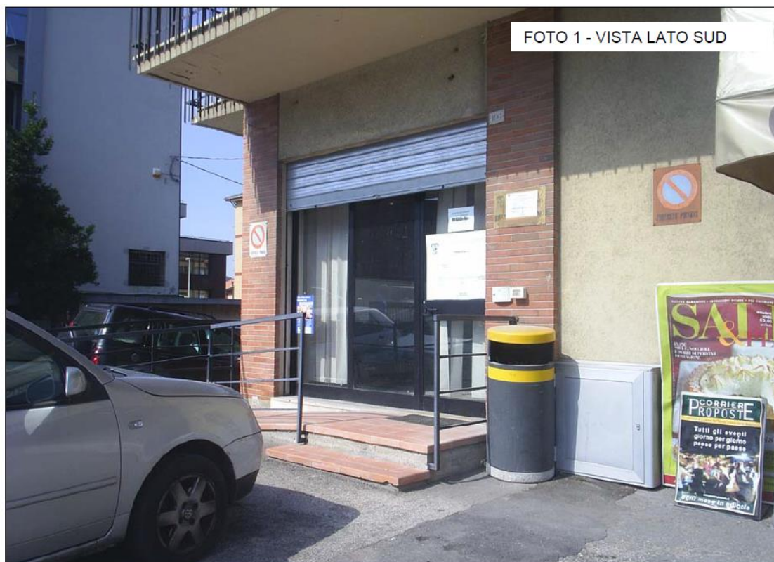
4. Foto vista lato sud.
