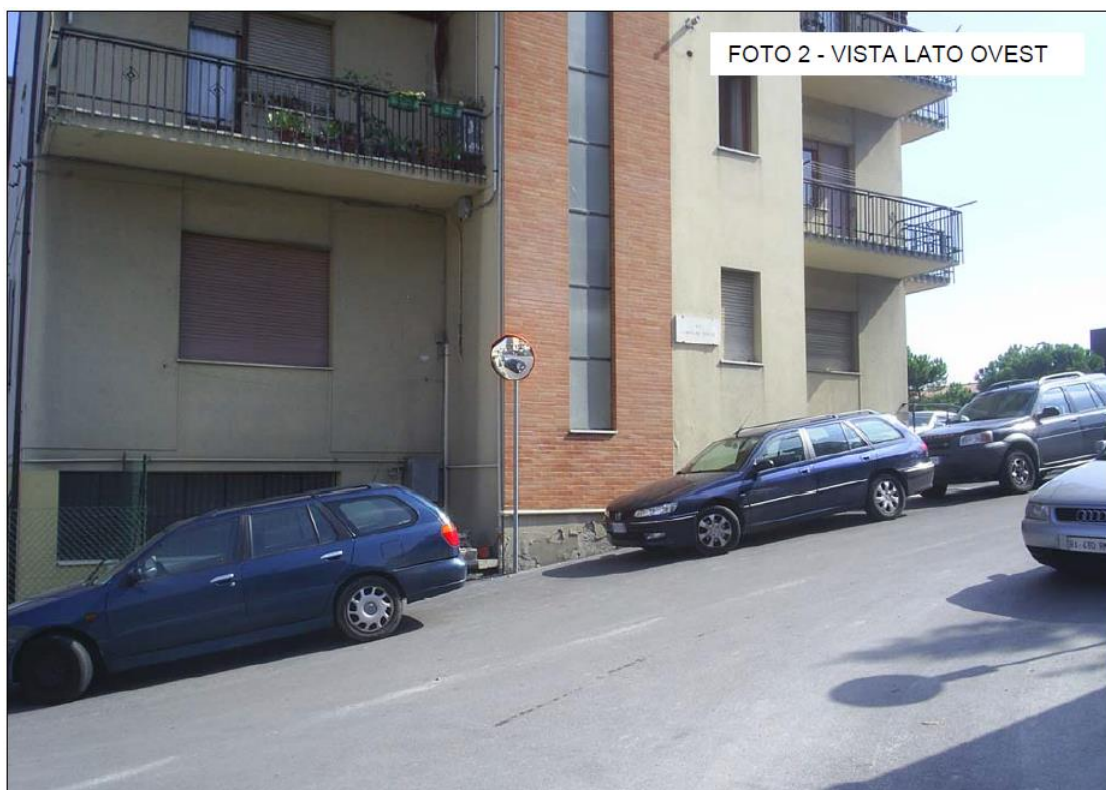
5. Foto vista lato ovest.
