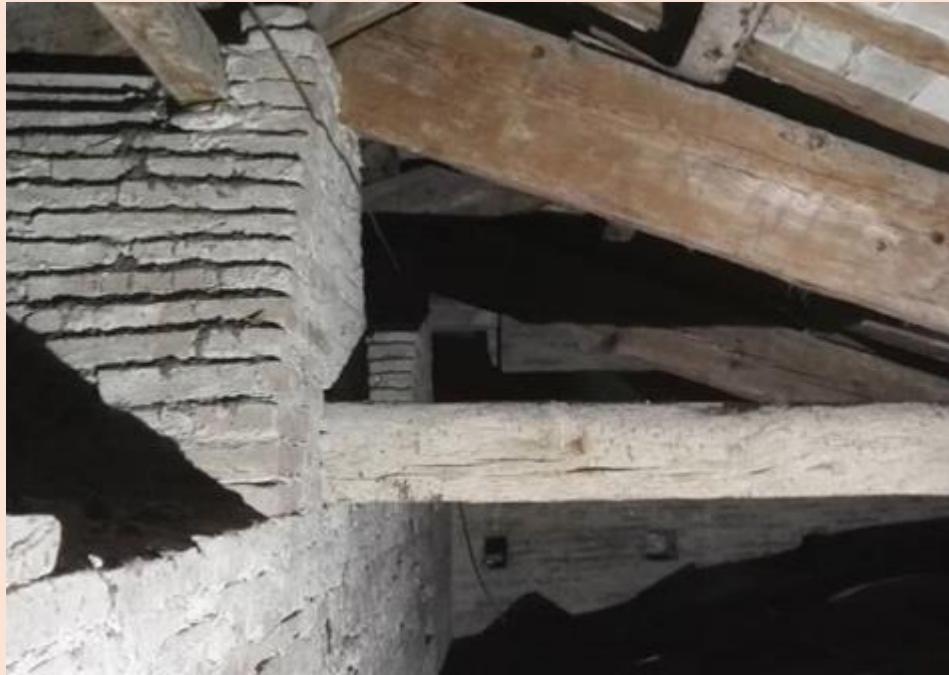
Sottotetto: muro centrale
