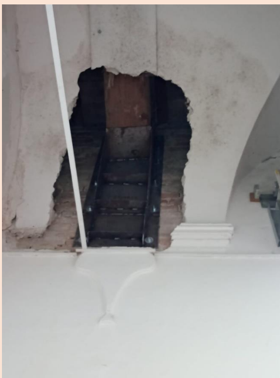
Aula 206: particolare elementi decorativi, controsoffitto originale in camorcanna e elementi strutturali di copertura
