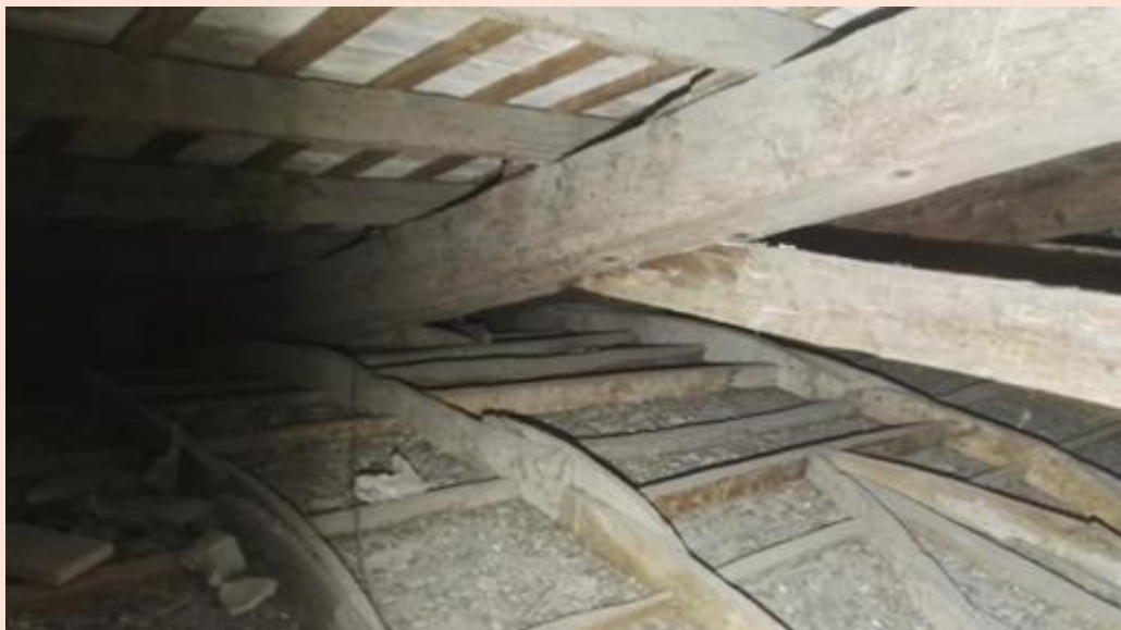
Sottotetto: particolare elementi in legno e controsoffitto in camorcanna
