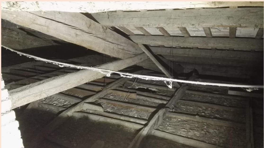
Sottotetto: particolare elementi in legno e controsoffitto in camorcanna
