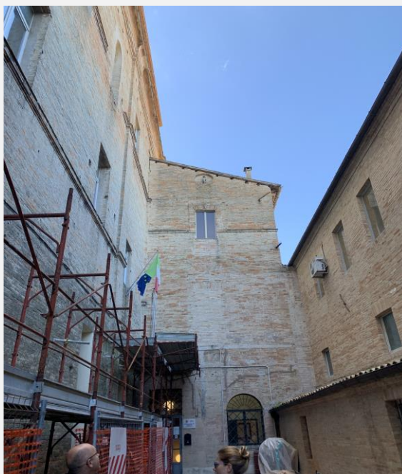
Ingresso principale: vista prospetto est
