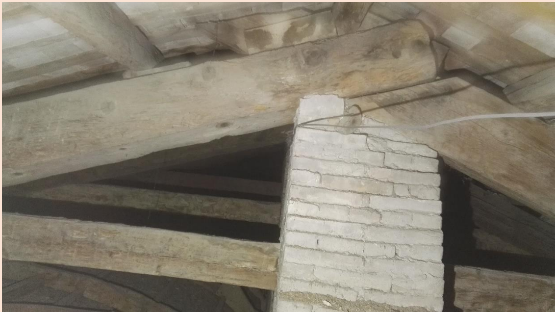
Sottotetto: particolare nodo della capriata
