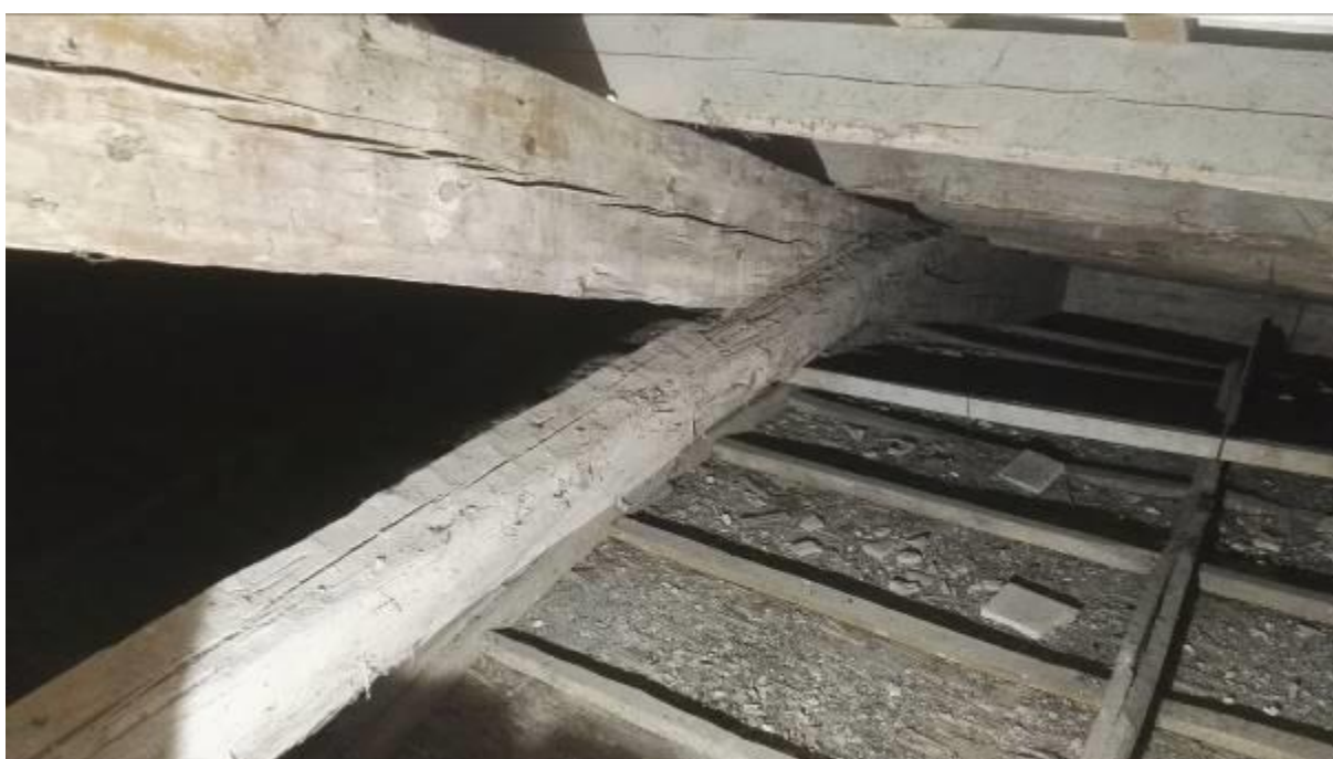
Immagine n. 8 – Vista della struttura del tetto attuale
