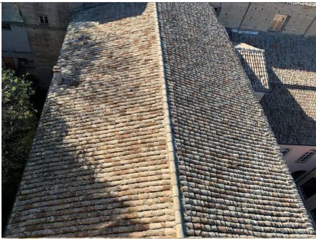
Immagine n. 4 – Vista della copertura da Nord
