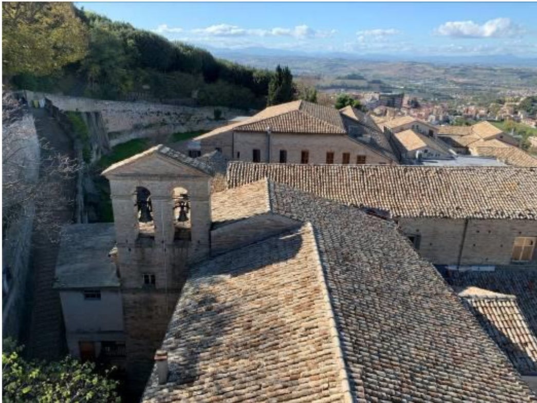
Immagine n. 3 – Vista della copertura da Nord
