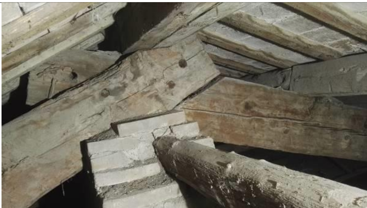
Immagine n. 9 – Vista della struttura del tetto attuale
