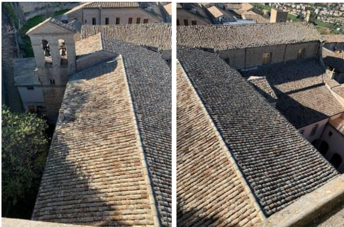
Immagini n. 5 e 6 - Viste della copertura da Nord
