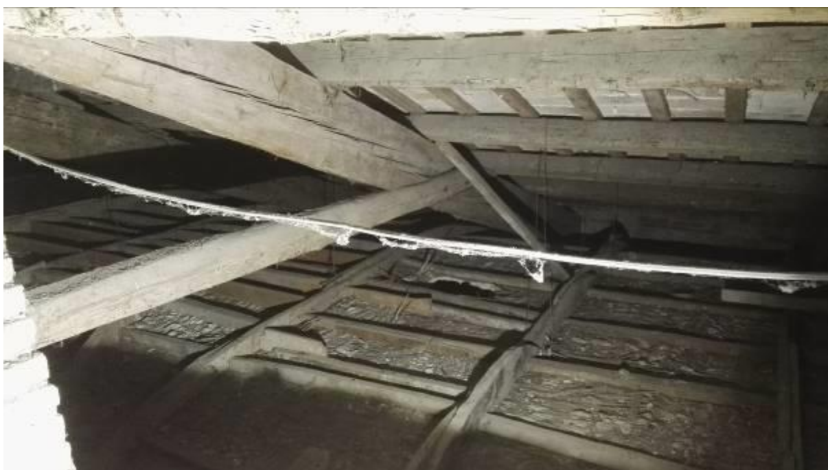
Immagine n. 10 – Vista della struttura del tetto attuale
