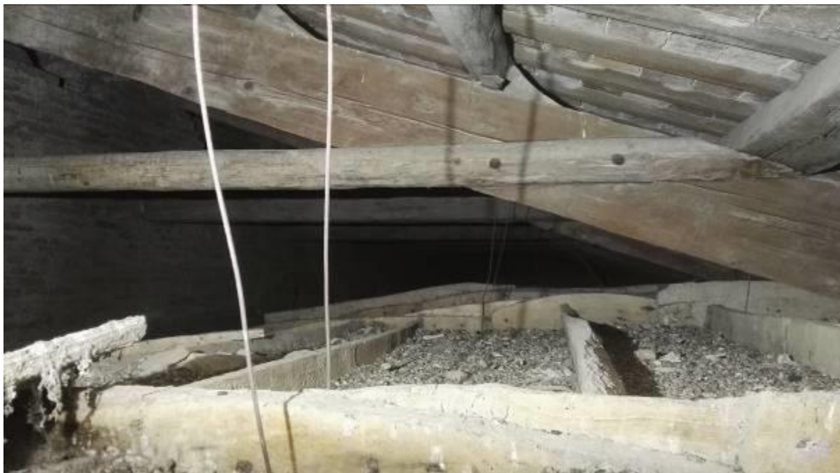
Immagine n. 7 – Vista della struttura del tetto attuale
