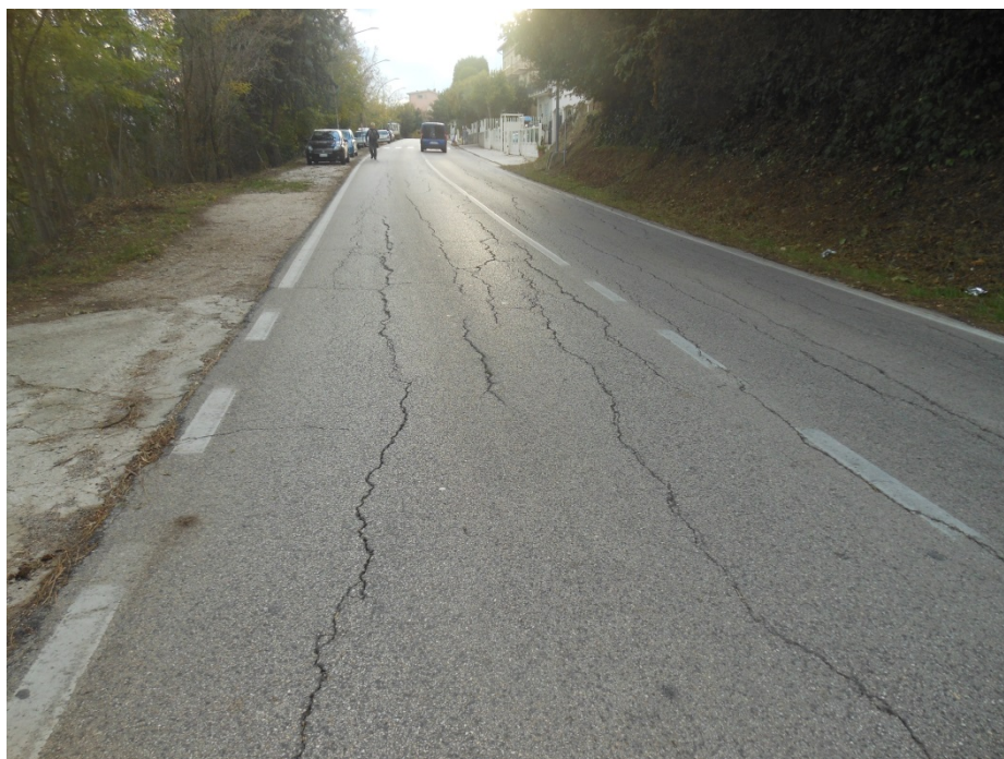
Foto1 - Fessurazioni longitudinali della pavimentazione stradale ed usura dello strato superficiale.
