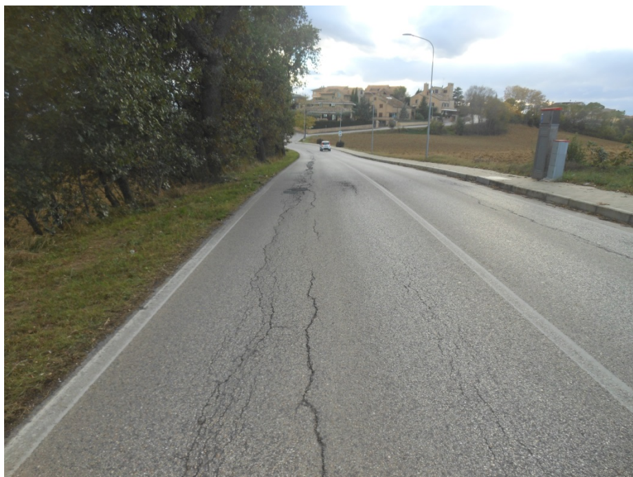
Foto 4 - Fessurazioni longitudinali della pavimentazione stradale, ed usura dello strato superficiale
