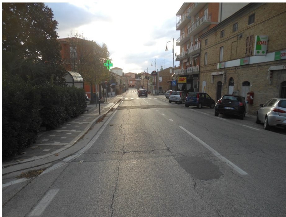
Foto 3 - Fessurazioni longitudinali della pavimentazione stradale, connesse anche alla presenza di sottoservizi, ed usura dello strato superficiale
