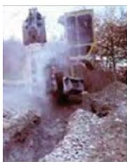
Per scavi a sezione ristretta (o in trincea) si intendono quelli continui (correnti) di sezione trasversale ristretta per i quali, non essendo consentito ai mezzi di trasporto per il carico dei materiali l'accesso frontale al fondo del cavo, si rendono necessari due paleggiamenti come per lo scavo a sezione obbligata. Generalmente, questi tipi di scavo vengono utilizzati per la posa di tubazioni, sottoservizi, ecc...
