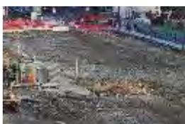
Il tracciamento dell'asse di scavo si realizza tracciando sul terreno una serie di punti fissi di direzione, che si trovano esattamente sulla direttrice di avanzamento, in modo da delineare all'impresa costruttrice il tracciato da eseguire. Il tracciamento viene eseguito mediante l'ausilio di modine o sagome, picchetti, distanziometri, ecc...
