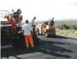
La fase di lavoro prevede la finitura del manto stradale formato da: conglomerato bituminoso (strato di base e binder) e tappetino di usura, stesi a caldo e di vario spessore. I vari strati sono stesi con vibrofinitrice, previo spandimento di bitume liquido su sottofondo già predisposto.
