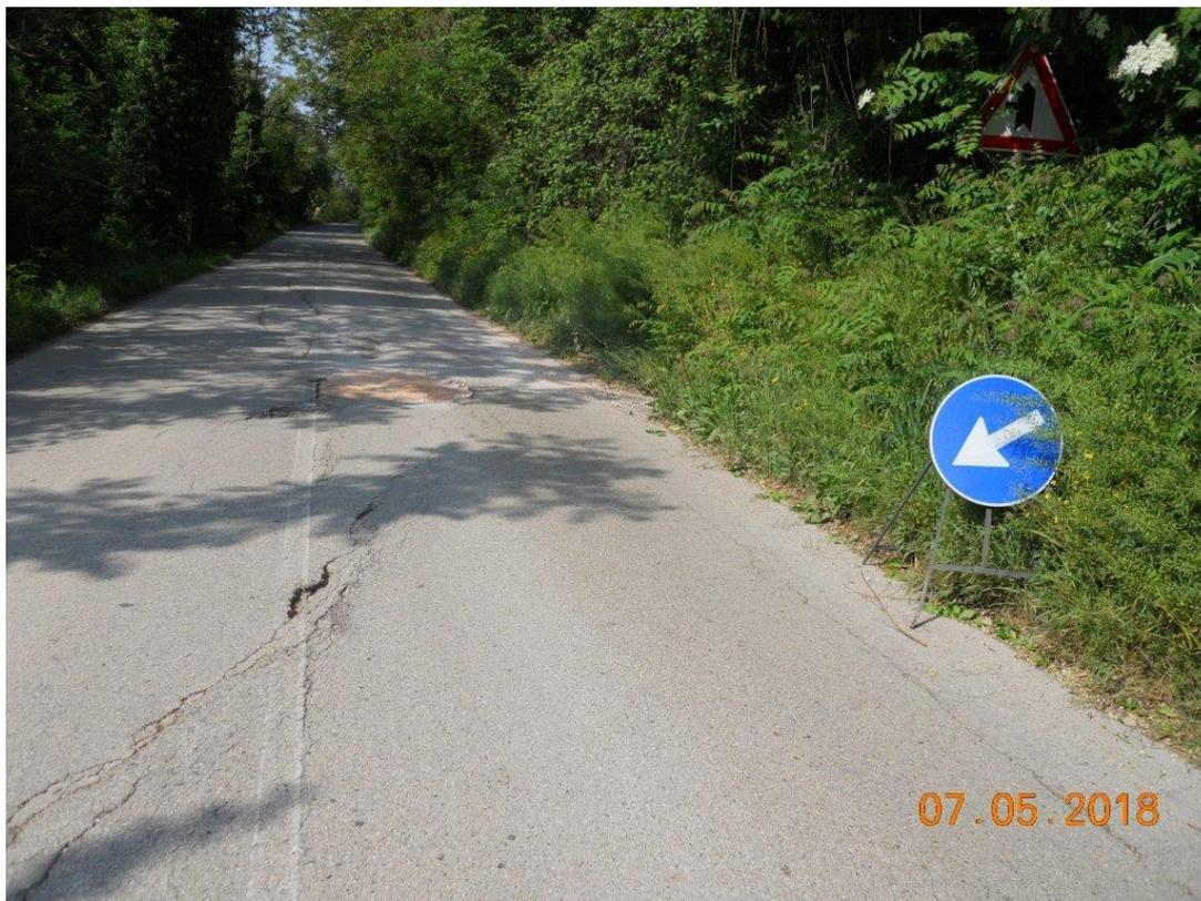
**Foto 1.** *Avvallamenti del piano viario con fessure longitudinali e trasversali della pavimentazione ed usura dello strato superficiale.*
