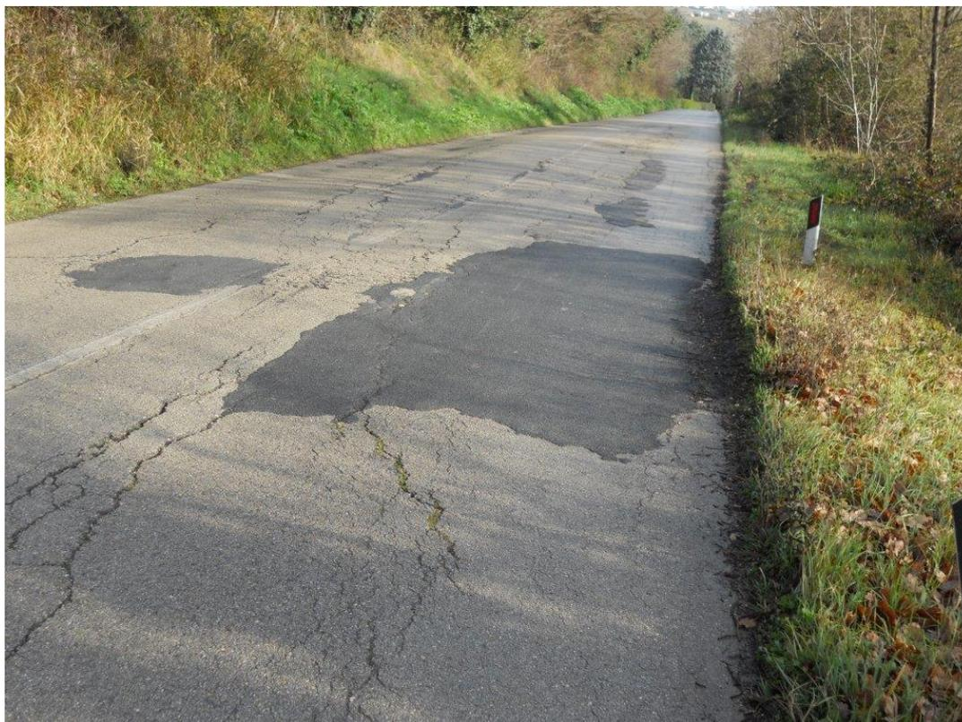
**Foto 2.** *Avvallamenti del piano viario con fessurazione longitudinale della pavimentazione stradale.*
