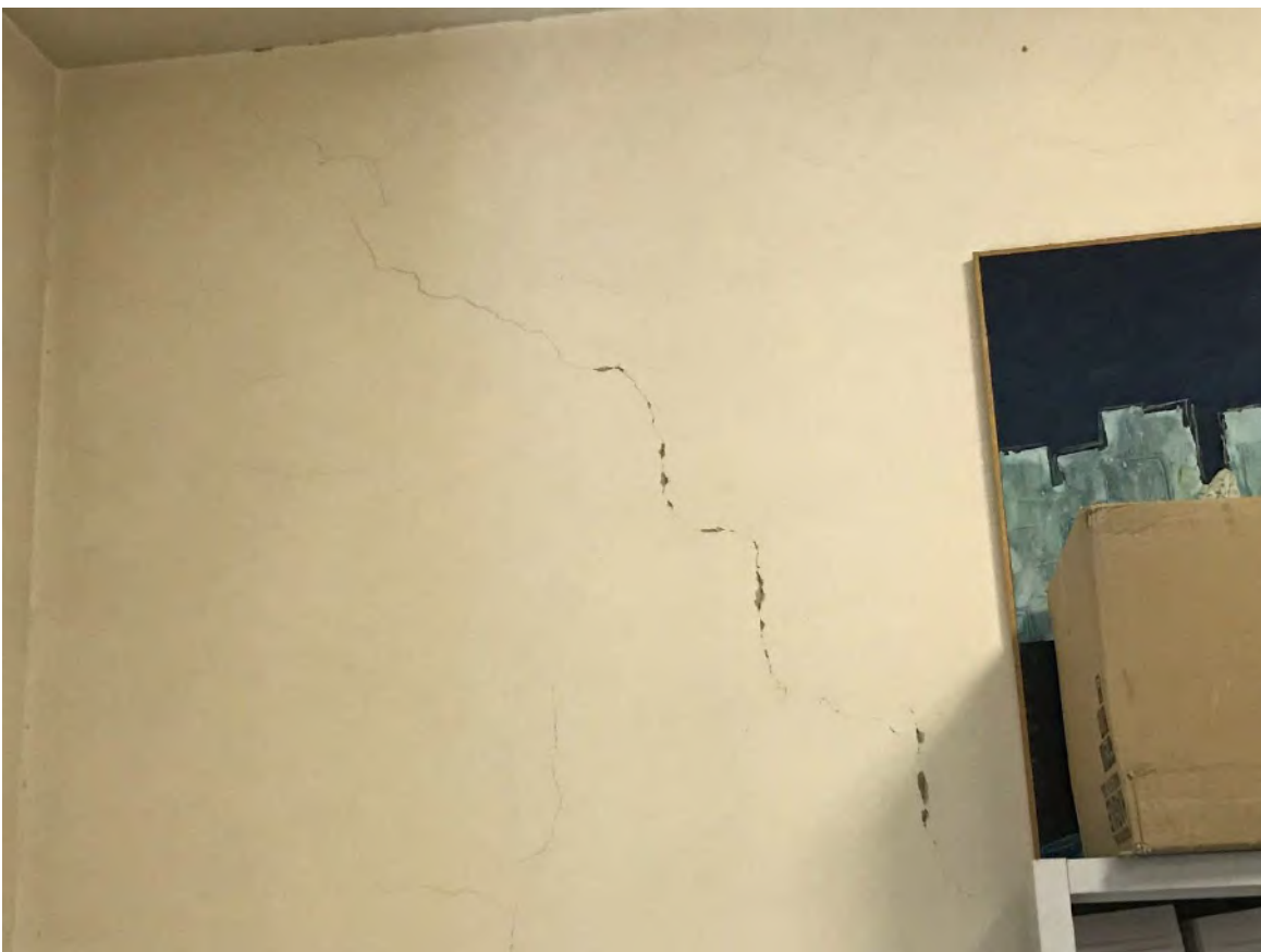
Figura 25: crisi per taglio di muratura (cono ottico 23)
