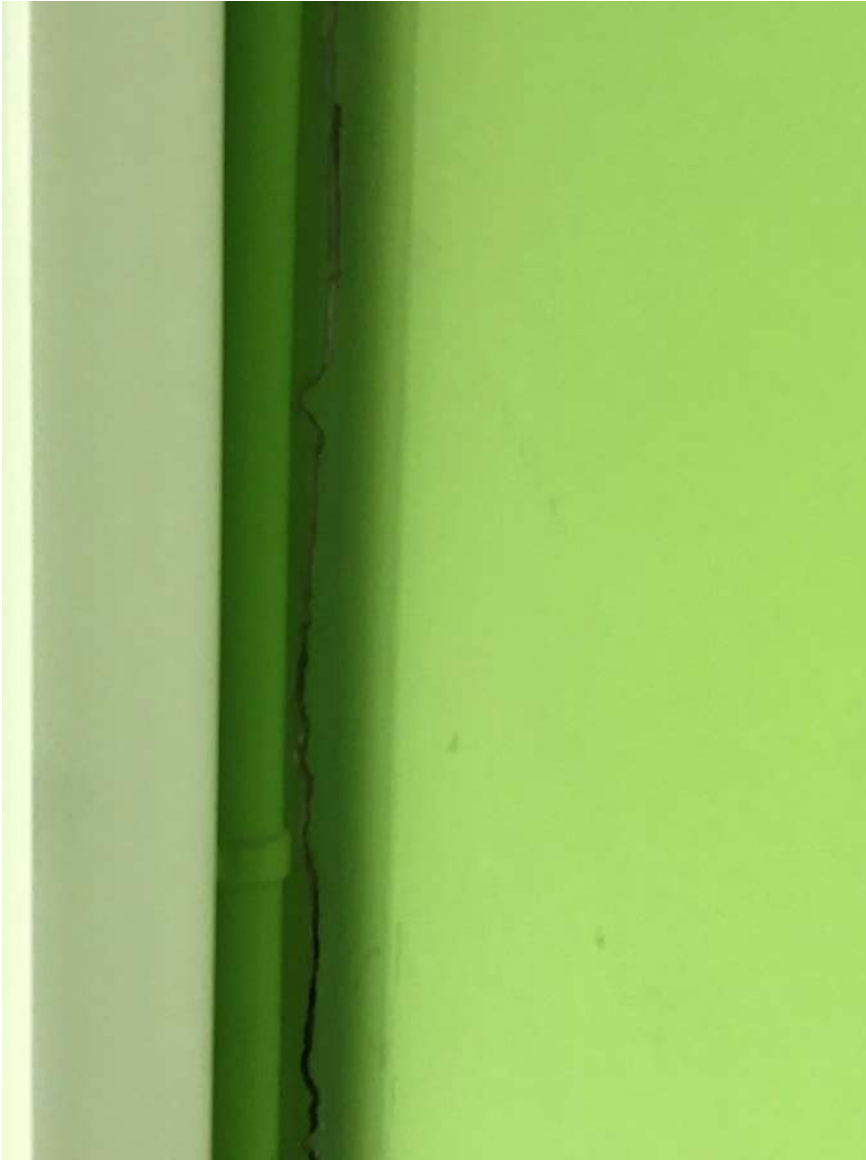
Figura 21: distacco fra pareti ortogonali (cono ottico 19)
