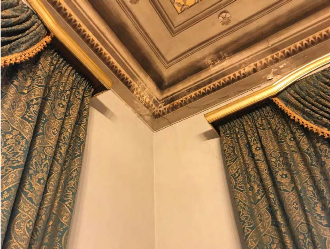
Figura 13: distacco orizzontamenti affrescati da murature portanti (cono ottico 11)
