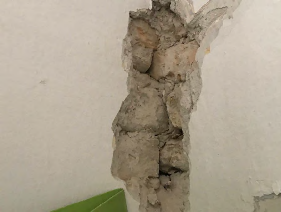
Figura 7: distacco di pareti ortogonali (cono ottico 5) (cono ottico 7)
