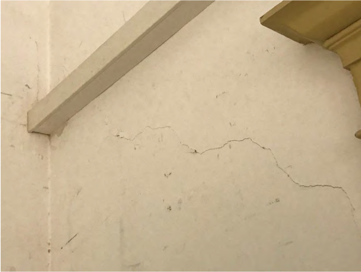
Figura 22: crisi per taglio di muratura (cono ottico 20)
