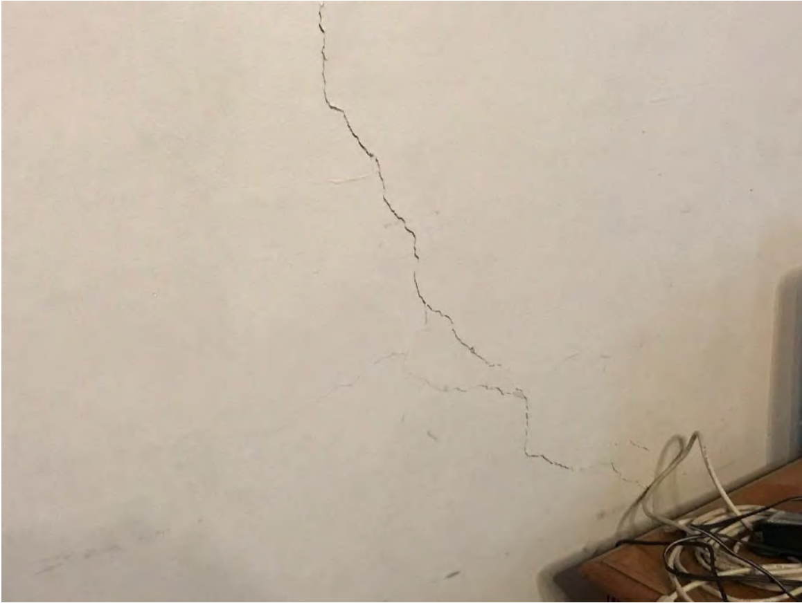
Figura 17: crisi per taglio di muratura (cono ottico 15)
