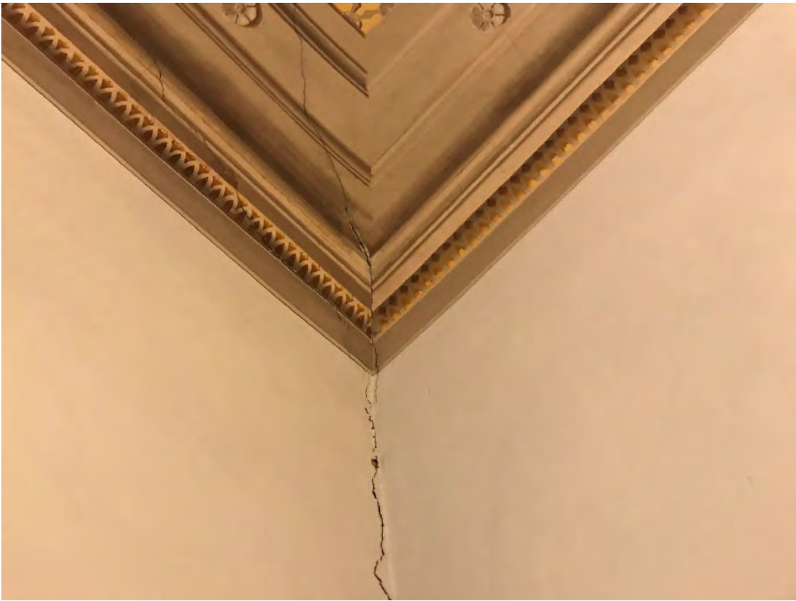
Figura 15: distacco orizzontamenti affrescati da murature portanti (cono ottico 13)
