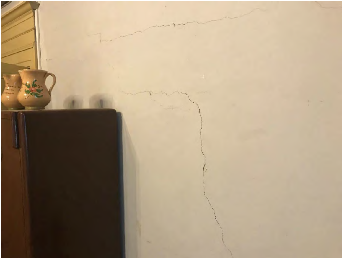
Figura 18: crisi per taglio di muratura (cono ottico 16)
