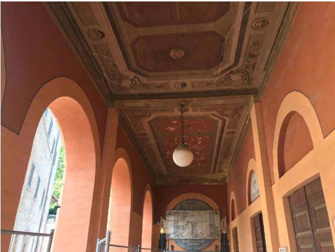
Figura 10: lesioni sugli orizzontamenti affrescati del loggiato (cono ottico 8)
