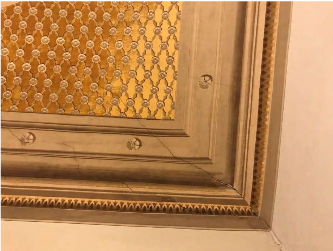
Figura 16: distacco orizzontamenti affrescati da murature portanti (cono ottico 14)
