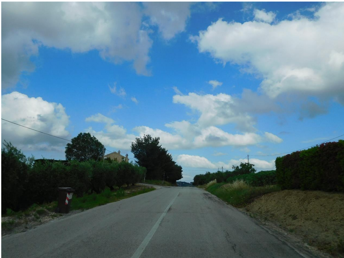
Foto 6. S.P. 11 - Km 5+900 - Fessurazione del bordo della pavimentazione stradale.
