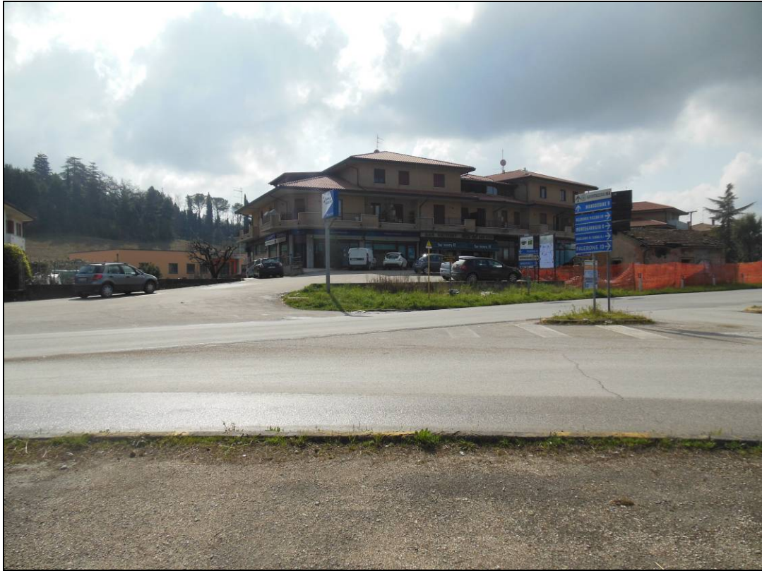
Foto 7 – Vista zona parcheggio, muretto di sottoscarpa
