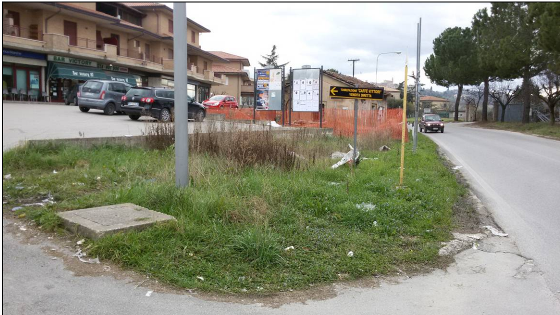
Foto 6 – Vista zona parcheggio, muretto di sottoscarpa
