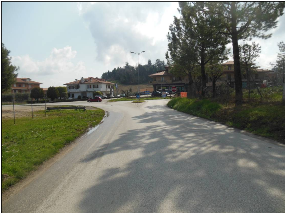
Foto 4 – Vista da S.P. 147 Vesciò Pescià
